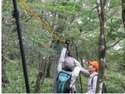
従来の柵の上に設置した飛び越え防止用ロープ
