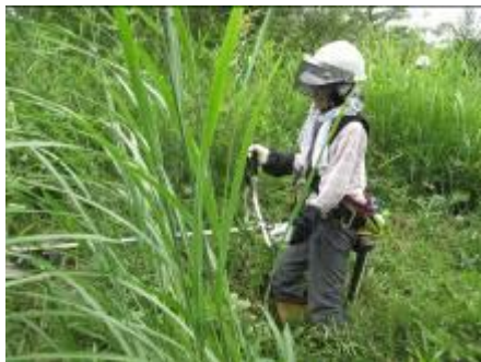
IMG2185 下草刈り準備作業中
