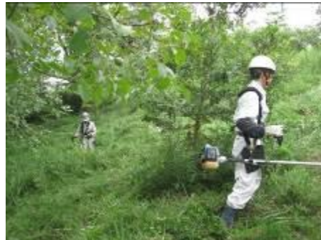
IMG2184 下草刈り準備作業中
